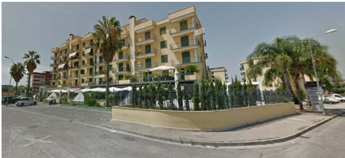
Fig. 1 Edificio caso studio
